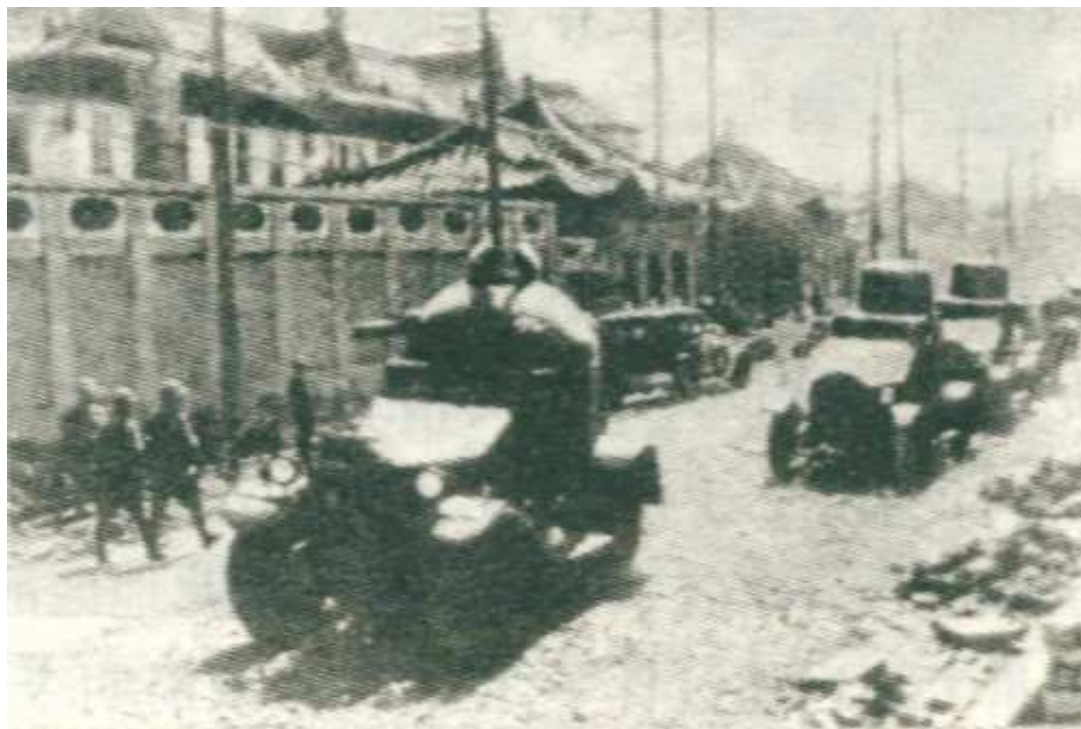
照片 3：拍摄时间约上午 11 点 30 分左右，地点同上。
